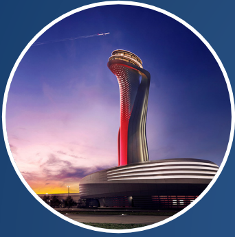
İstanbul Havalimanı Şantiyesi CCTV Sistemi
